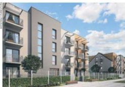
Elewacja zewnętrzna zostanie wykonana tylnym w dwóch różnych kolorach popielatego oraz drewnem aklimatyzowanym w kolorze ciepłego brzoza
