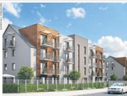
Pod domami przewidziano są parkingi, na których zmieści się 160 aut. Gdzieś będą mogły parkować nawet bezdomni
